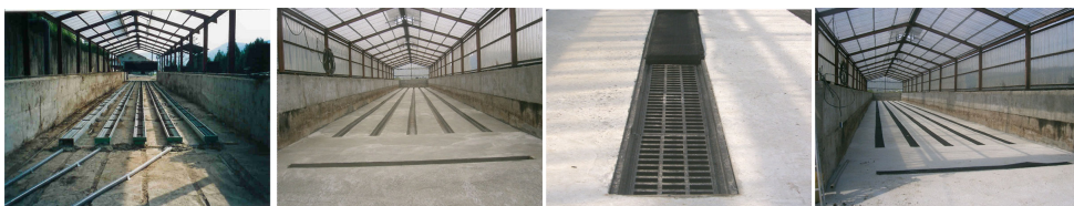
(송풍라인 및 바닥 피트) (조립식 배출틀) (공사 완료)
