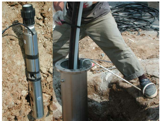
② 관정 내 심정펌프 설치
