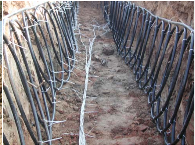
② 수평형 지열교환기 설치
