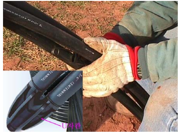
② 수직형 지열교환기 설치
