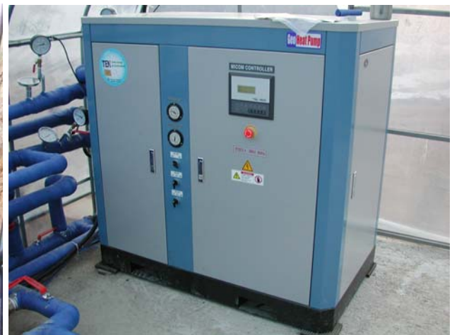
④ 배관 및 지열히트펌프 설치
