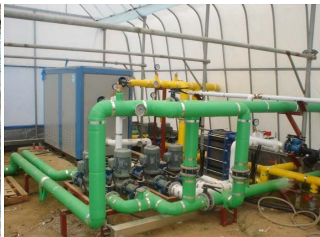
④ 배관 및 지열히트펌프설치
