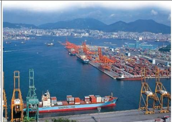
〈감만부두 및 신선대부두의 전경〉
