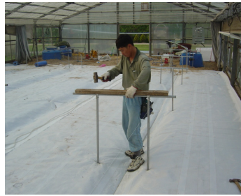
〈벤치 다리 설치〉
