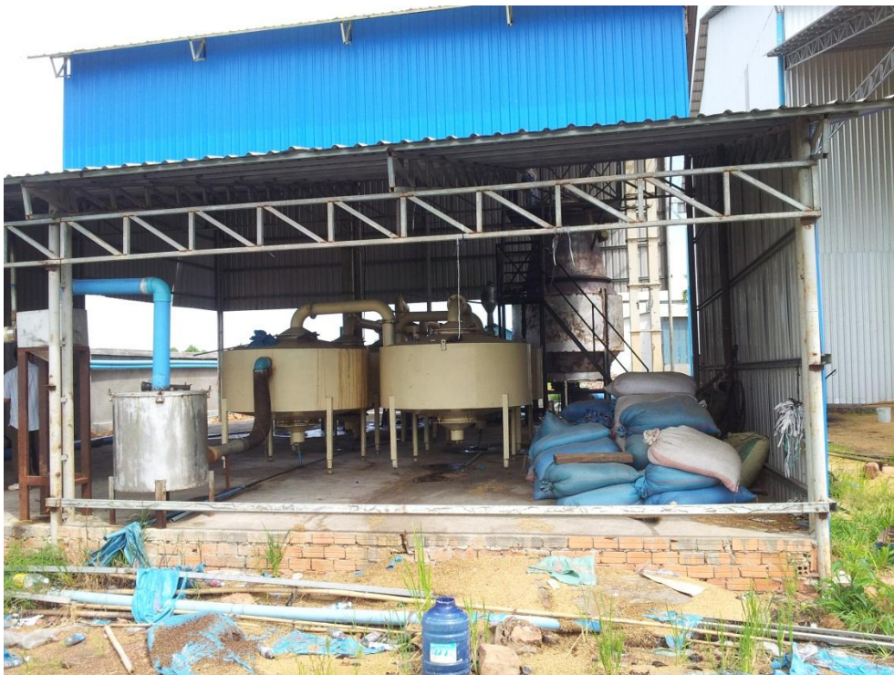
[사진 : 짬퐁짬 바띠에이군의 도정공장에서 왕겨를 이용한 발전설비가 가동되고 있다. 김우택제공]
